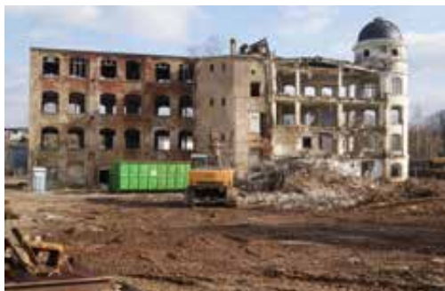
Abbruch der LISEMA-Gebäude, 2017 Foto: Dr. Reinhard Jeromin
