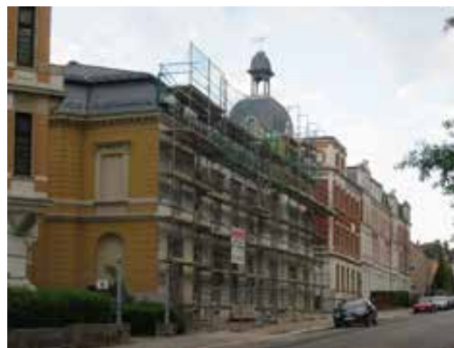
Frankenberg, ehemaliges Postgebäude, derzeit im Umbau zur Jugendkunstschule Foto: Falk-Uwe Langer
