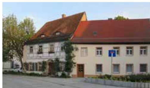
links: Frankenger, Badergasse 4/5, vor Baubeginn, 2009 Foto: Falk-Uwe Langer
