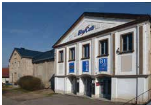
links: Frankenberg, Welt-Theater vor der Sanierung, 2009 Foto: Falk-Uwe Langer
