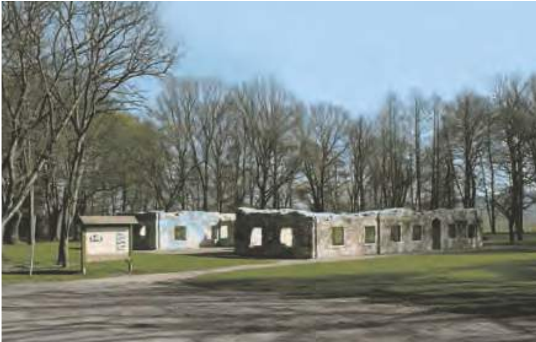
Schloss Großzscheпа, Zustand nach Abbruch mit Resten des Erdgeschosses Foto: Jürgen Schmidt
