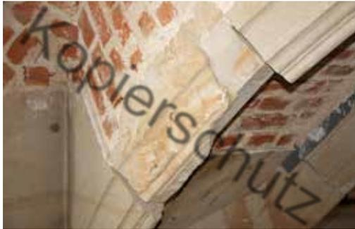
Versetzen eines Schlingrippenwerkstücks auf Lehrgerüst und Hilfsunterstützungen
