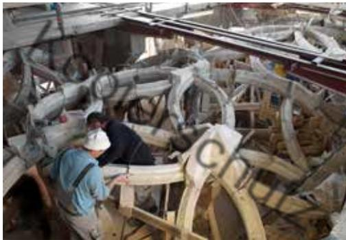
Stahlrahmengerüst mit Schnürboden als Arbeitsebene für Lehrgerüst des Gewölbes
