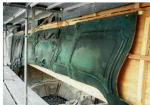
zwischen restaurierten Kupferteile durch die Kupferklempner an die Holzunterkonstruktion angebracht werden. Beginnend mit der Stehfalz-Kupferdeckung der Dachflächen, der elektrisch temperierten Liegerinnen zur Dachentwässerung und der Attika mit den Flammenvasen wurden dann die Wappenkartuschen mit den Kronen und der Engelgruppe angebracht. Blech um Blech folgte nun das „Ankleiden“ der neuen Konstruktion mit den ornamentierten Kupferteilen.<sup>43</sup>
