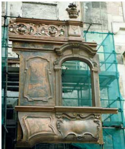
Probeachse mit restaurierten Kupferteilen der Theaterplatzseite, angebracht vor der Fassade der Hofkirche unterhalb der alten Anbindung der Brücke. Dort ist noch die vermauerte Türöffnung zu sehen. 1994.
