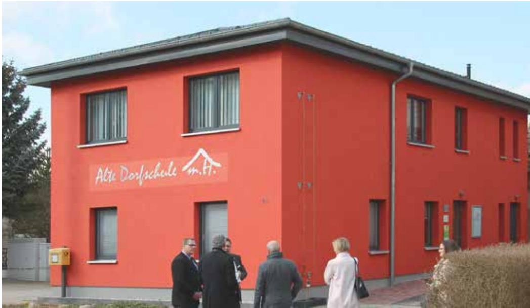
Das ehemalige Heimatvereinshaus wurde durch die Gemeinde Thallwitz mithilfe einer LEADER-Förderung in Höhe von rund 77.000 Euro sowie Bundesmitteln umgebaut und saniert. Als „Multiples Haus“ bündelt es jetzt verschiedene Einrichtungen (Dienstleistungen, gesundheitliche Vorsorge, Vereinsraum) für die örtliche Bevölkerung. Foto: Henning Kuschnig
