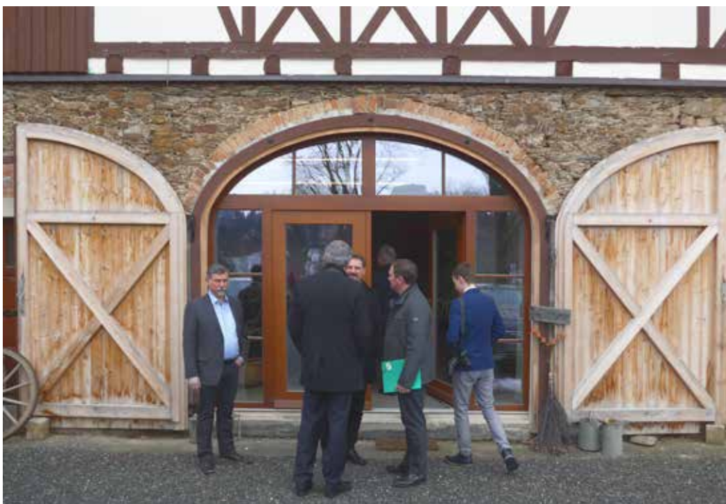
Die ortsbildprägende und unter Denkmalschutz stehende Scheune in Drebach OT Griebbach wurde mit LEADER-Mitteln saniert und zu Wohnraum umgebaut. Denkmalschutz und moderne Photovoltaik in der Außenhülle wurden in Einklang gebracht. Der Zuschuss betrug rund 66.000 Euro. Foto: Henning Kuschnig
