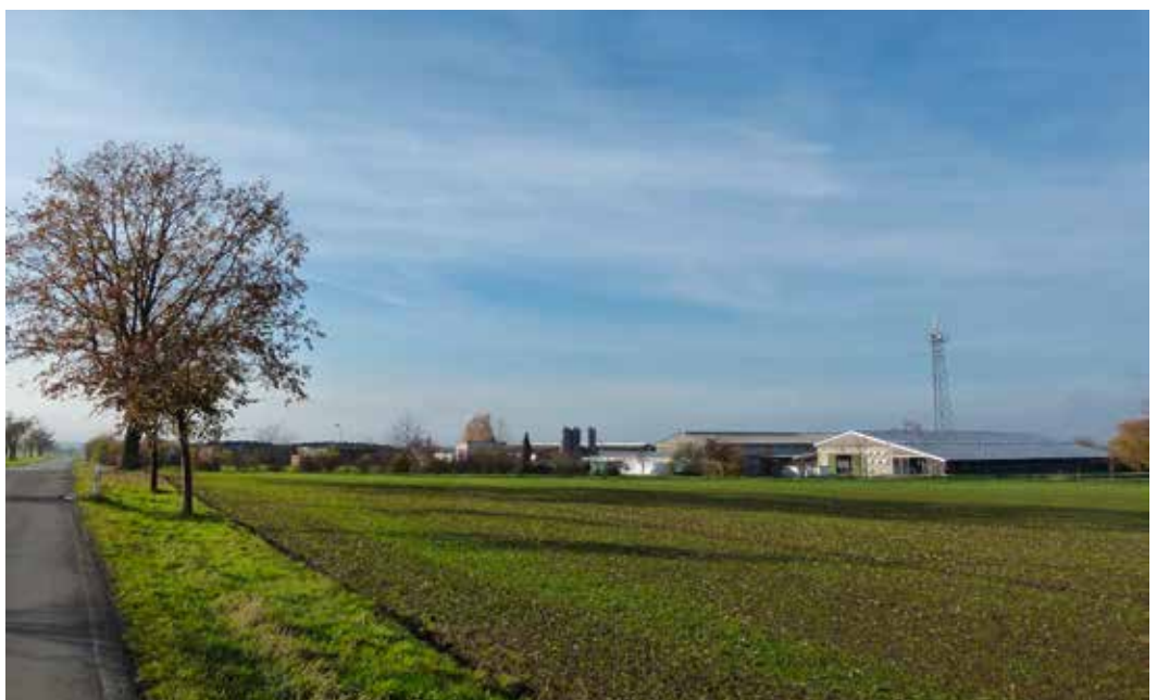
Betriebsgelände der Agrargenossenschaft Kohren-Sahlis Foto: Dirk Martin Mütze
