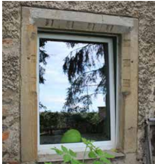
links: Herrenhaus Lötzschen, Fenstergewände mit Diamantquadrern
