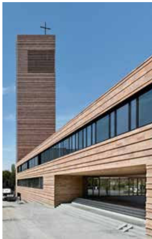
Neue Propsteikirche St. Trinitatis in Leipzig, Fassade an der Nonnenmühlgasse Foto: Stefan Müller
