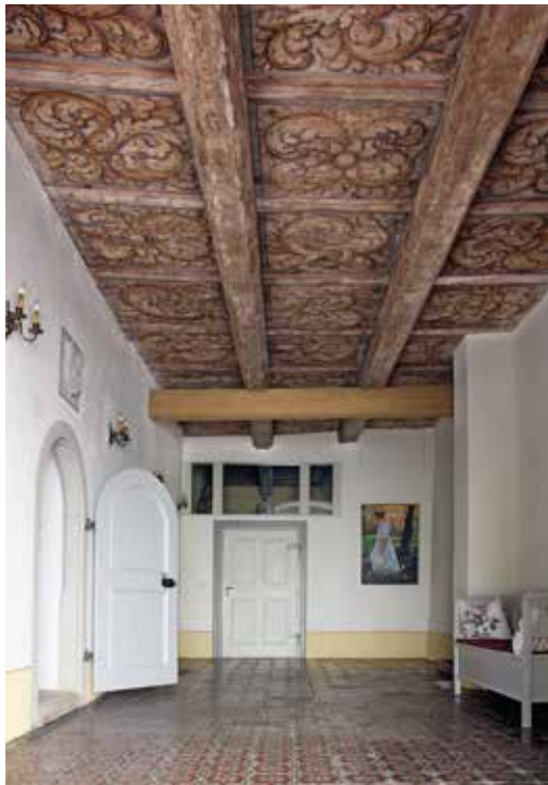
Herrenhaus Niederjahna, Eingangshalle und Saal Foto: Matthias Donath
