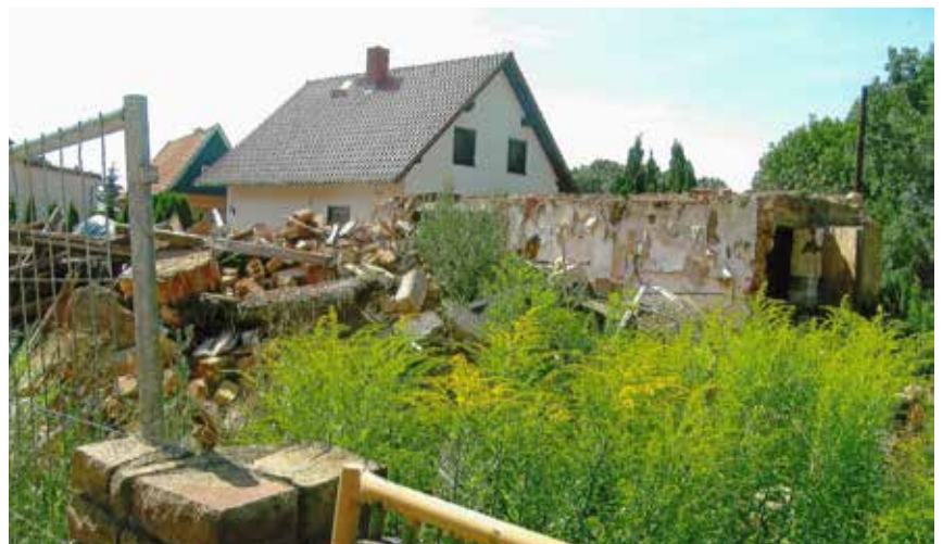
Kein Umbau oder Nachnutzung, sondern Abriss und Neubau © Wilfried Wehner
