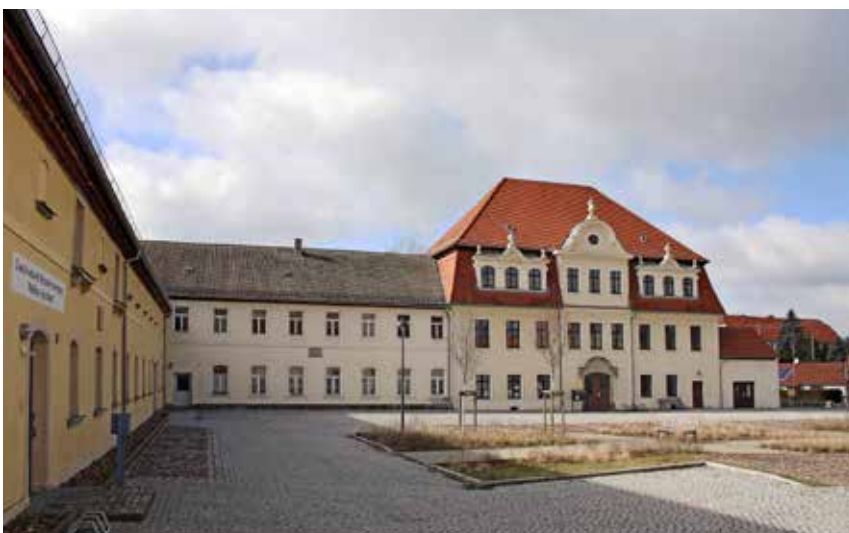
Rittergut Raußnitz, ehemals dörflicher Mittelpunkt und Sitz der Gemeindeverwaltung Ketzerbachtal, jetzt weitgehend leerstehend Foto: Matthias Donath
