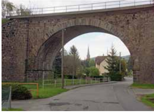
Viadukt mit Stadtkirche Altlöbau
