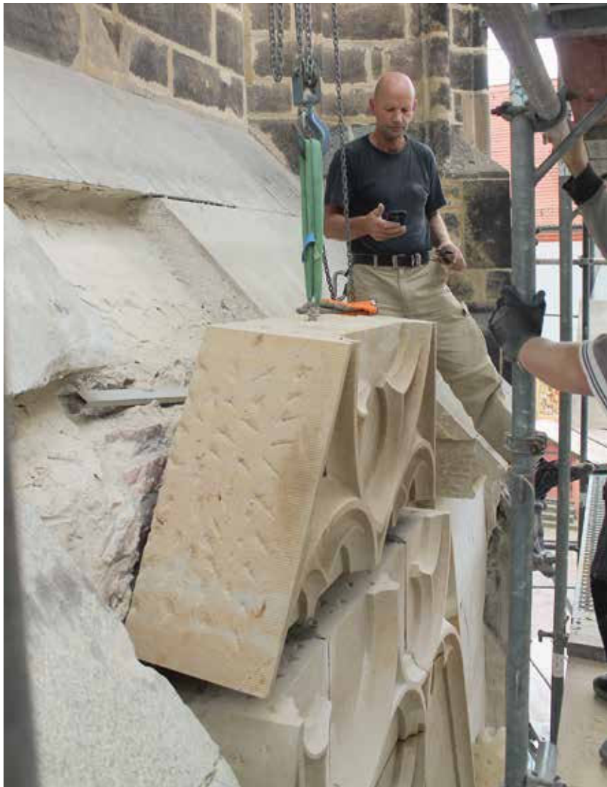
Das Aufsetzen eines Werksteins des Wimperges am Portal des Meißner Domes, 2014.
