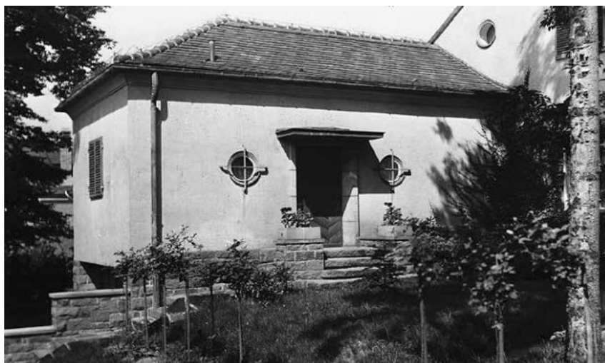
Anbau einer Arztpraxis an ein Wohnhaus in Döbeln.
