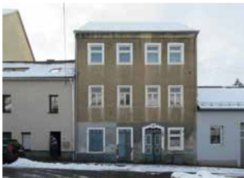
Frankenberg, Gartenstraße 37 Foto: Falk-Uwe Langer
