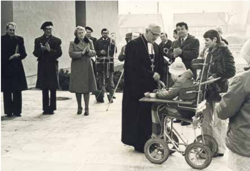
Katharinenhof Großhennersdorf, Einweihung des Schwerstbehin- dertenwohnheims, 1983 Archiv Katharinenhof Großhennersdorf
