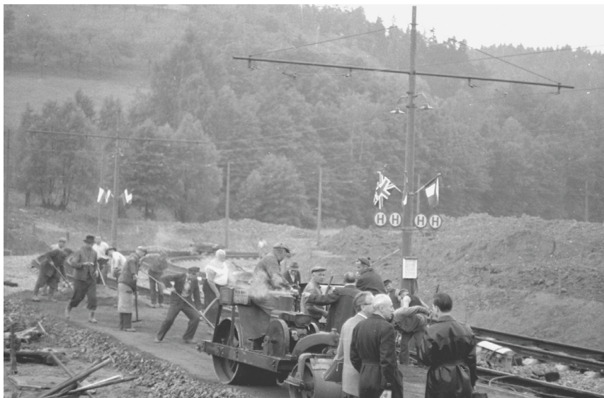
Bau der Straßenbahngleisschleife in Hainsberg-Coßmannsdorf anlässlich der Kanuslalom-Weltmeisterschaft im Rabenauer Grund 1961 Städtische Sammlungen Freital, Archiv, Foto: Siegfried Huth
