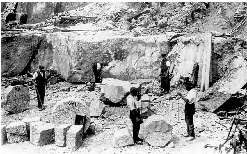
Herstellung von Mühlsteinen im Steinbruch Schwarzes Loch, um 1900 Städtische Museen Zittau
