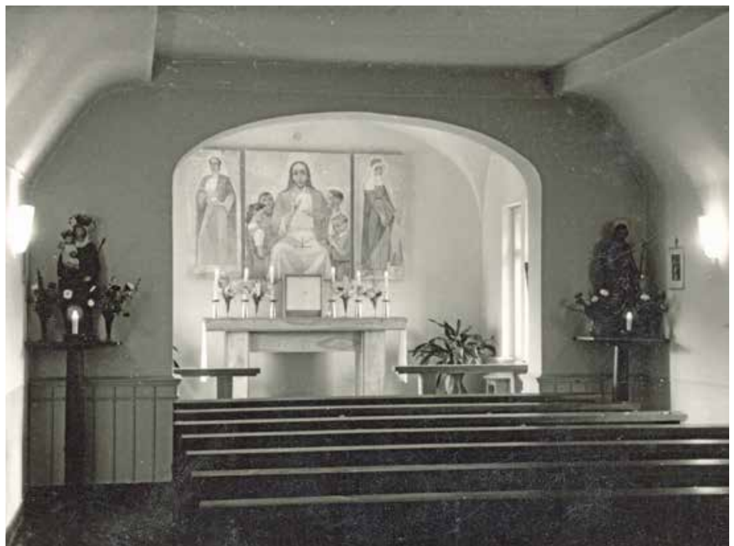
Katholische Kapelle im Schloss Thammenhain, hier Zustand der 1960er Jahre
