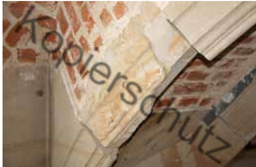
Ein aus dem Schutt geborgenes Schlingrippen-Werkstück wurde wieder mit eingebaut Foto: Rainer Böhme
