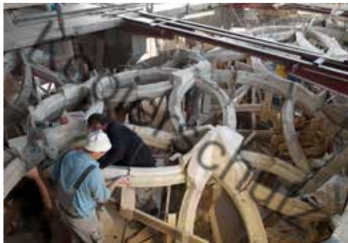
Versetzen eines Schlingrippenwerkstücks auf Lehrgerüst und Hilfsunterstützungen Foto: Rainer Böhme
