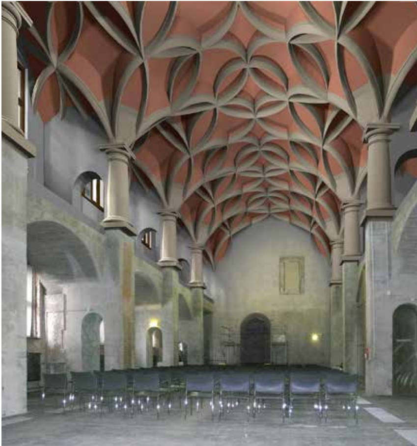
Residenzschloss Dresden, Simulation des Schlingrippengewölbes in der Schlosskapelle, um 2010 © Architekturbüro Anwand, Dresden
