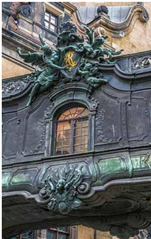
Unterkonstruktion den ornamentierten und ausgezierten Kupferblechen der Hülle der Brücke Halt geben sollten. Die Eisenkonstruktion wurde durch die Stahlbaufirma Kelle & Hildebrand, Dresden, ausgeführt, die am 29. März 1898 für das Material 6.022,-Mark. und für die Montagearbeiten 10.805,14 Mark veranschlagte.<sup>17</sup>
