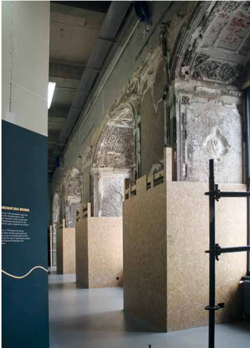
Großer Ballsaal, Rohbauzustand mit Resten der Stuckaturen, 2020 Foto: Romy Donath
