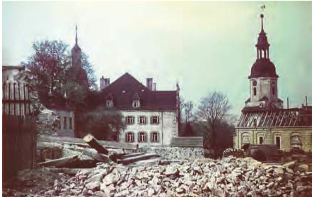
Rittergut Thammenhain, Abbruch der Wirtschaftsgebäude und der Hofkirche (rechts), 1949
