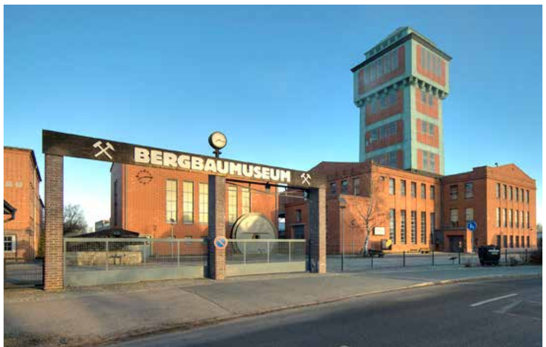
Heute ist der frühere Kaiserin-Augusta-Schacht als Museum des sächsischen Steinkohlenbergbaues ein authentischer Ort sächsischer Industriekultur. Mit der Schauplatzausstellung KohleBoom ist das Bergbaumuseum Teil der 4. Sächsischen Landesausstellung. Einzigartige, spannende und überraschende Geschichte(n) zu Entstehung, Gewinnung und Verarbeitung der Steinkohle werden lebendig. Foto: Arndt Gaube
