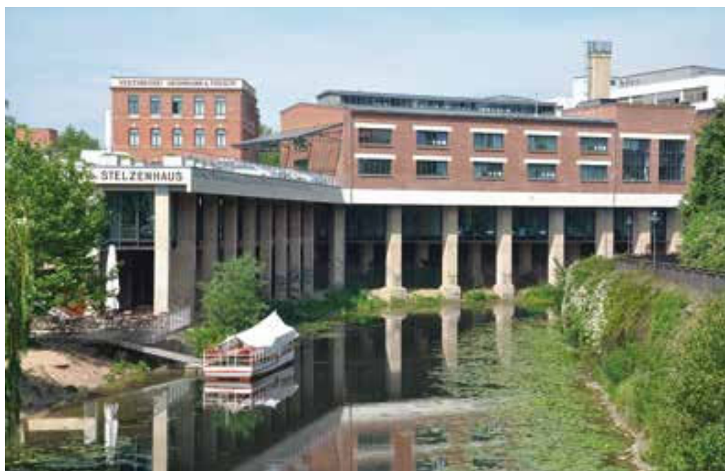
Neues Leben im alten Industriebau: das Stelzenhaus nach Sanierung und Umbau zum Wohn- und Bürostandort, 2014. Foto: Arnold Bartetzky
