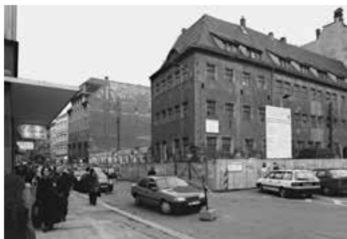
Rettung eines untergangsgeweihten Baudenkmals: die Alte Nikolaischule zu Beginn der Restaurierung, 1992
