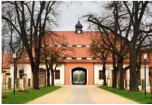
Torhaus des Hauptgestüttes Graditz Foto: Jens Ziegenbalg
