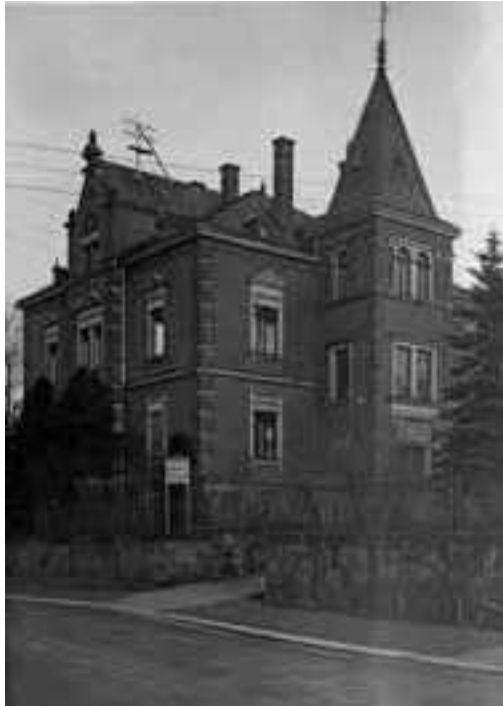
Limbach-Oberfrohna, Frohnbachstraße 12, Wohn- und Verwaltungsgebäude der Handschuhfabrik Carl R. Fritzsche, Baumeister Hermann Täschner, heute Wohnhaus © Familie Täschner
