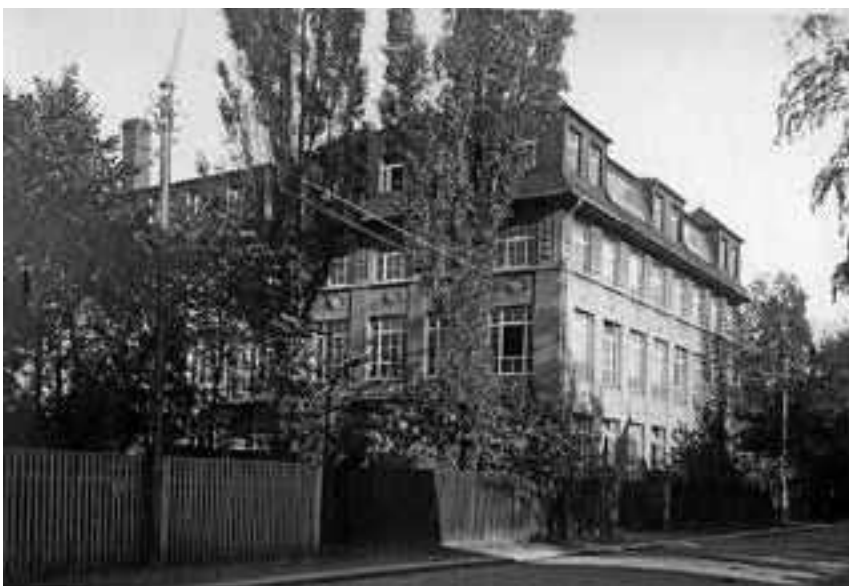
Limbach-Oberfrohna, Straße des Friedens 68, Produktionsgebäude der Kunstschmiede und Metallwarenfabrik August Mann & Söhne, Baumeister Hermann Täschner, heute Gewerbepark © Familie Täschner
