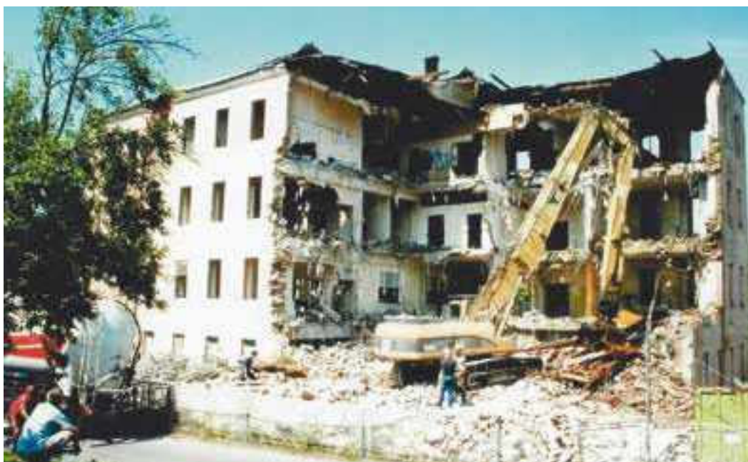
Abbruch der Industriebrache des VEB Malitex, 2008
