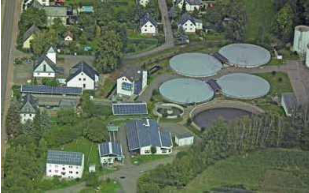
Zentrale Kläranlage des Zweckverbandes Frohnbach. Links Gebäude mit Photovoltaikanlagen, rechts Bioreaktoren mit Zeltabdeckung zur Sammlung von Klärgas für die anschließende Verstromung im Stirling-Motor © ZV Frohnbach
