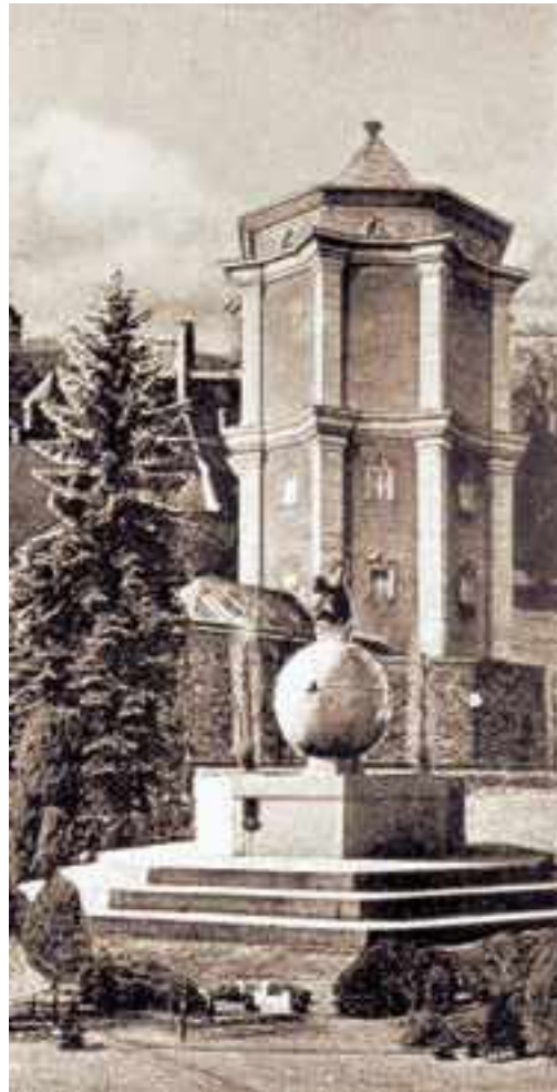
Wasserturm, 1920er Jahre
